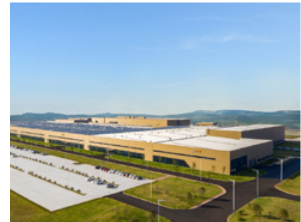
国机汽车新能源汽车工厂全景
