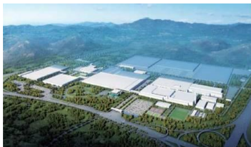
北京现代全厂项目
